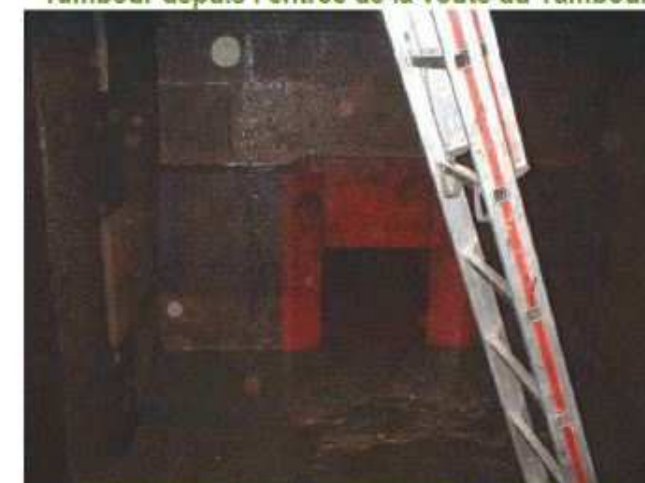
Orifice de vidange (alimentant la conduite de vidange)
