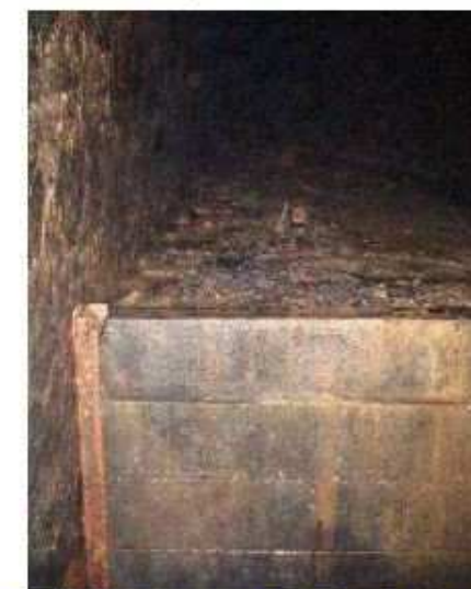
Batardeau en poutrelles bois à quelques mètres de l'extrémité aval de la voûte d'Enfer
