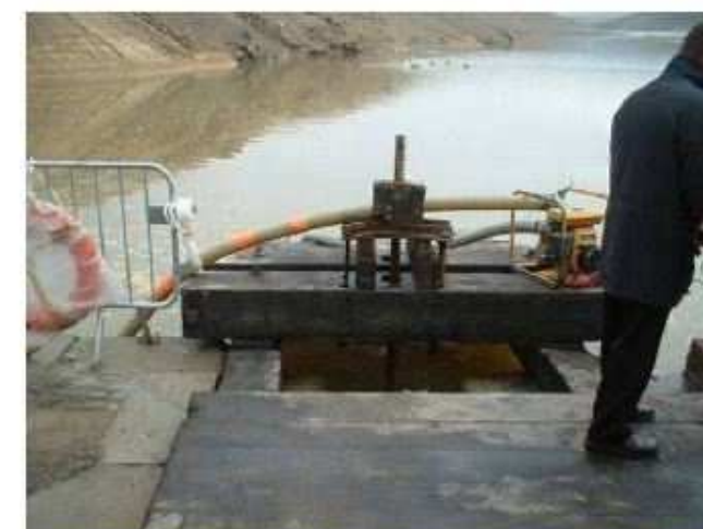
Dispositif de manœuvre des vannes de fond et du Tambour depuis l'entrée de la voûte du Tambour
