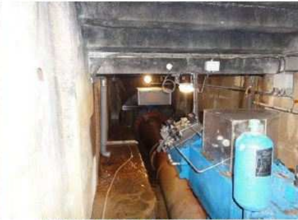
Conduite de vidange et vannes de vidange dans la chambre des vannes
