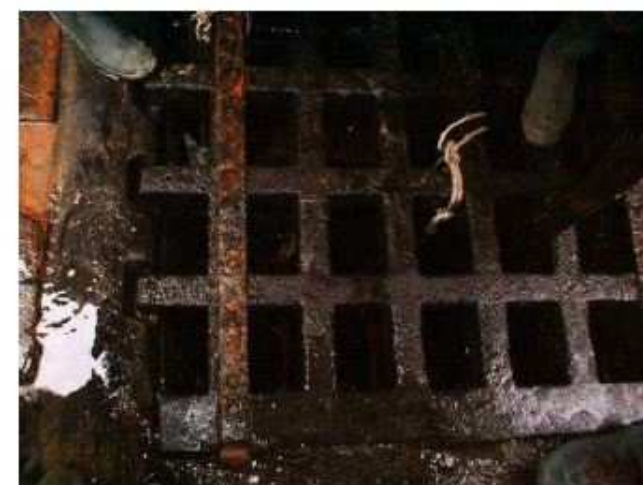
Grille d'entrée du puits vertical
